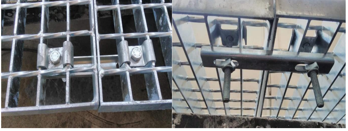
Izgara Bağlantı Elemanları
